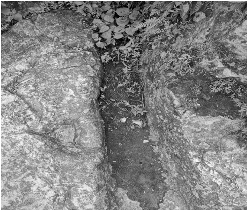
Figura 12. Canal labrado en la roca madre contiguo al cerro el Mirador. Foto: Rubén Nieto H.
